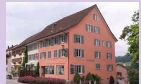
Haus Zum Ochsen 4 Wohnungen mit Balkon und grossen Küchen, Kostümverleih Simsalabim Bistro Bechandra, Claroladen Büro WAK
