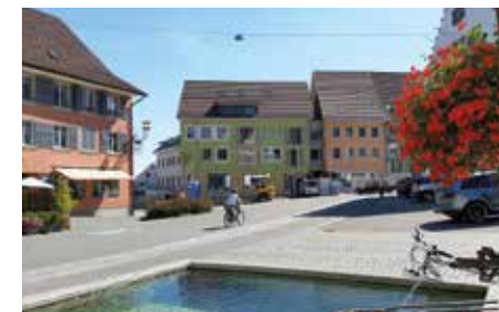
Bärenhof 10 Wohnungen mit Tiefgarage, Kultursaal WAK, Raiffeisenbank
