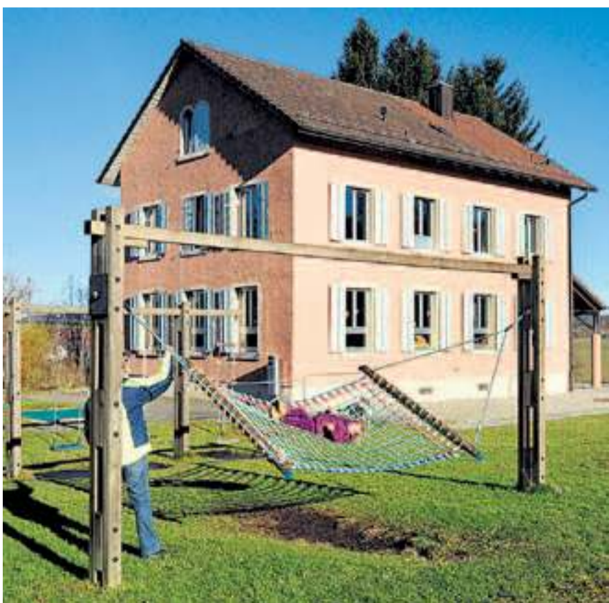
Die Tage des Kindergartens im alten Schulhaus scheinen gezählt. Bild: Marc Dahinden
