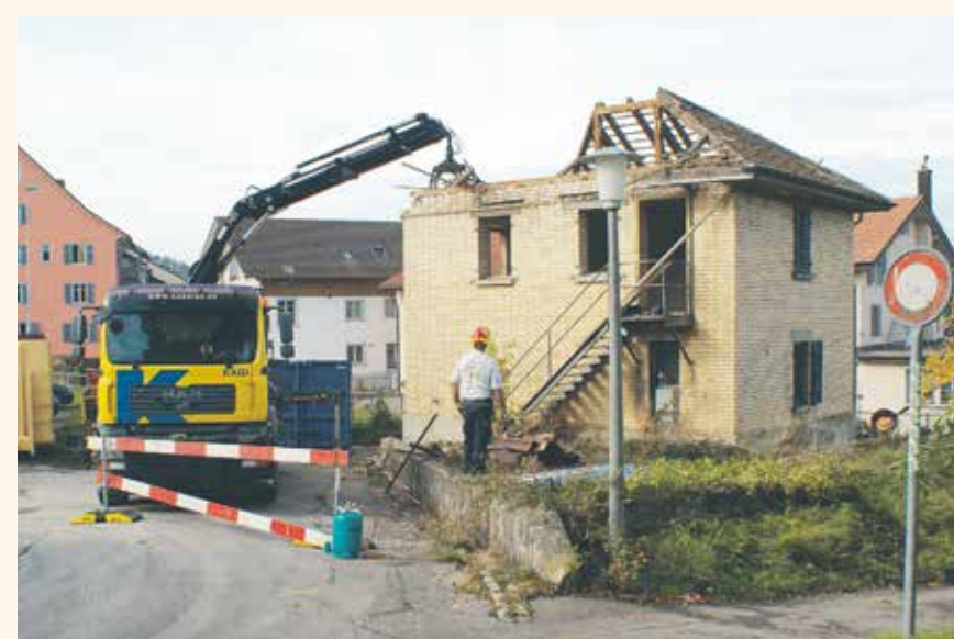
Abbrucharbeiten am Eiskeller im Oktober 2013.
