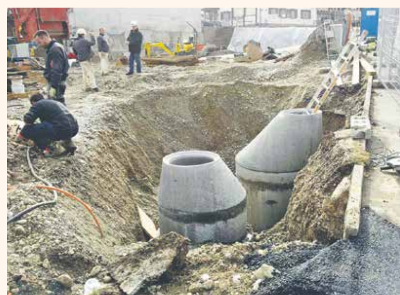
Kanalisationsarbeiten wurden im Februar 2014 in Angriff genommen.
