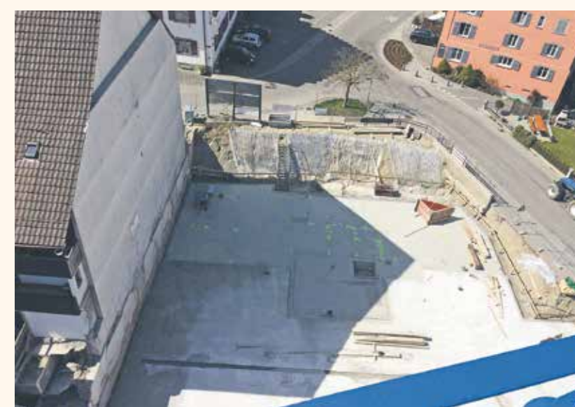
Einen Blick auf die Bodenplatte.
