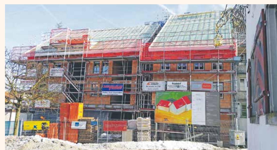
In der letzten Arbeitswoche im Dezember wurde die Rohbauabnahme durch die Baubehörden vorgenommen.
