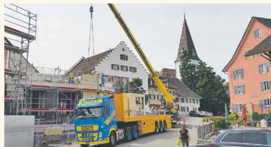
Lieferung und Montage der Sichtbetonelemente im August.
