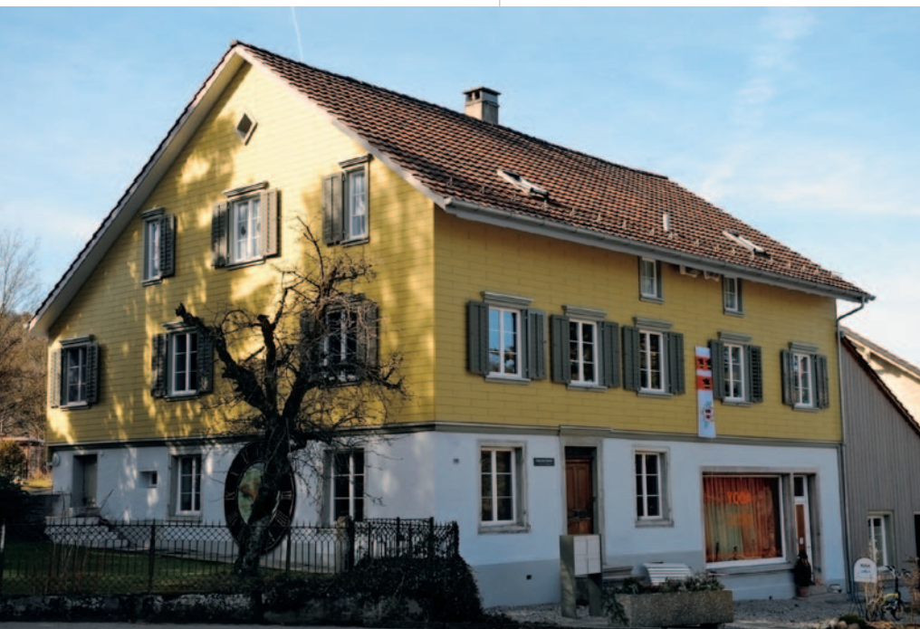
Das Haus zum Untertor war in einem schlechten Zustand, als die WAK es 2007 übernahm. Zur umfassenden Sanierung gehörte auch die Erneuerung der Fassade, die eine Aussenisolation erhielt.
