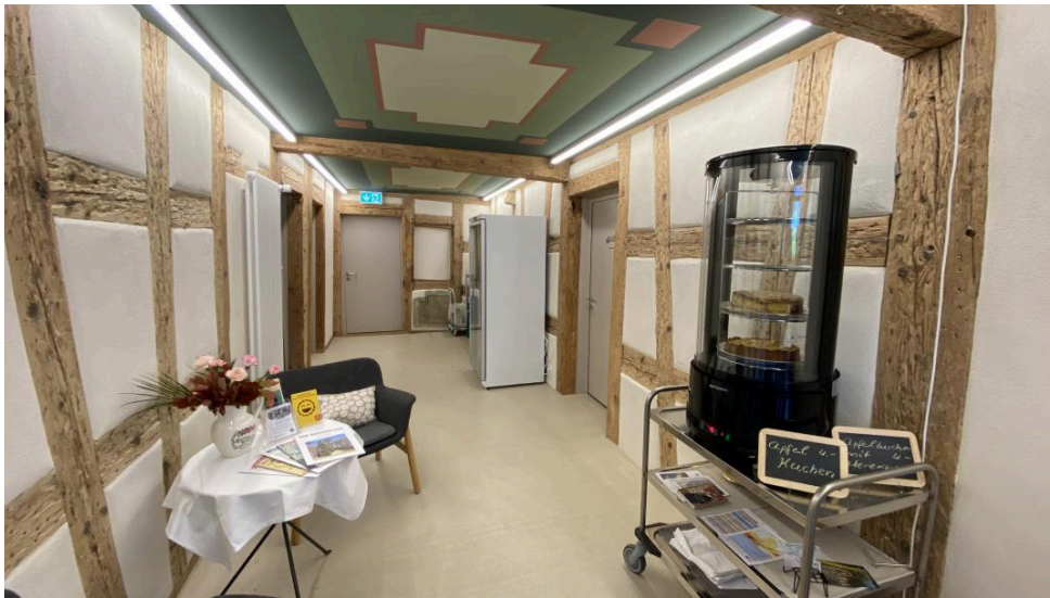
Die Unterermühle von innen - mit viel Sorgfalt in Bezug auf das baukulturelle Erbe saniert. Foto: Paul Dominik Hasler
